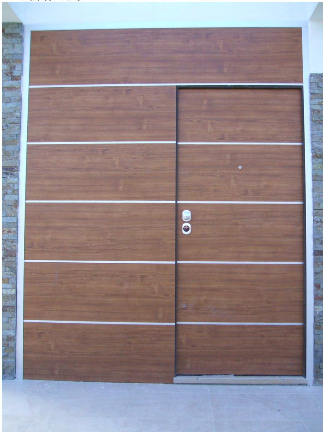
Morada na Moita Porta de entrada principal, revestida a painéis fenólicos.
