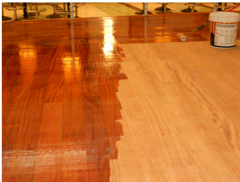
Reparação, lixagem e envernizamento do palco da zona da Restauração.
