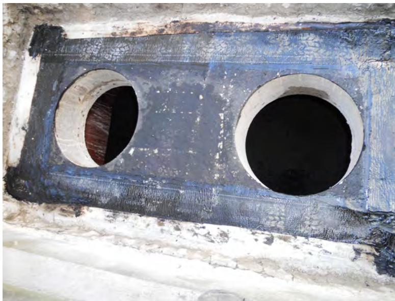
Abertura de carotes e construção de condutas de ventilação para restaurante.
