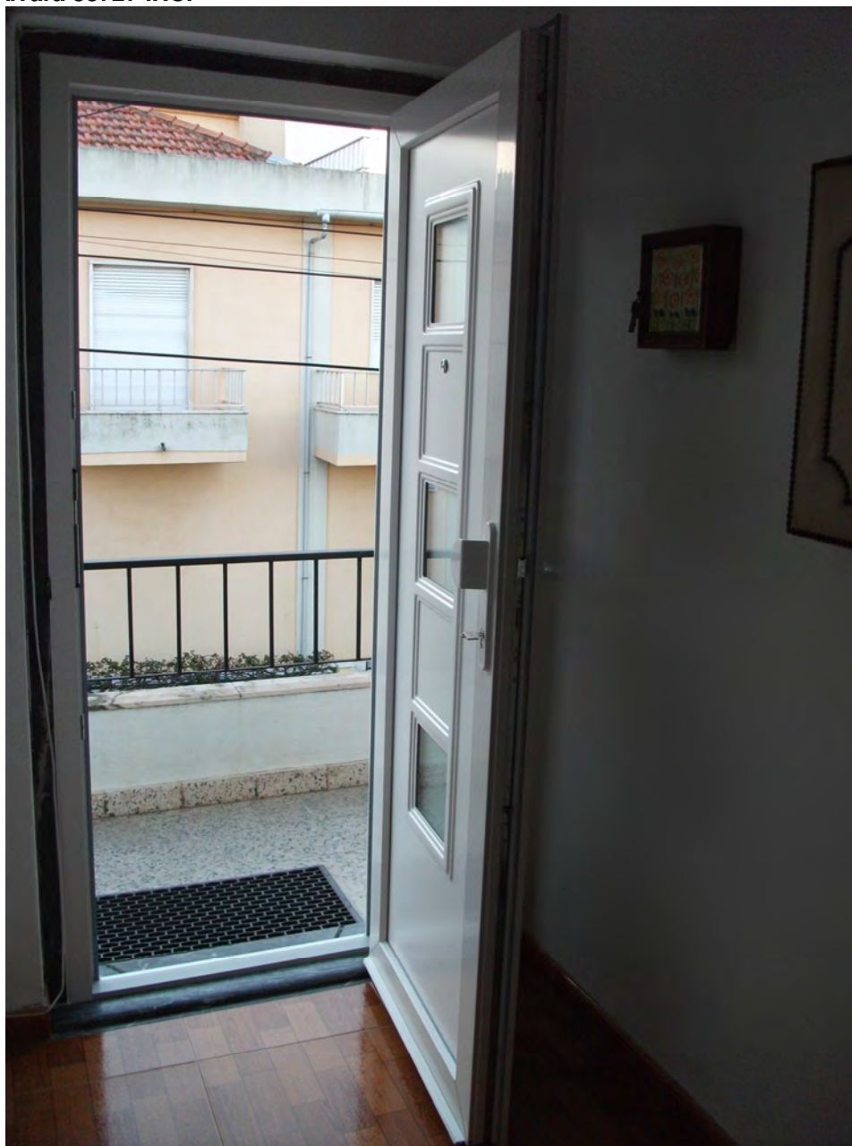
Renovação de caixilharias em moradia em Camarate Porta de entrada de PVC
