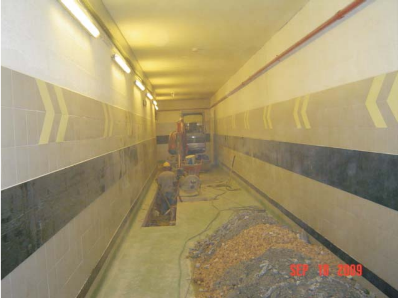
Centro Comercial CascaiShopping - Desvio de Esgotos
