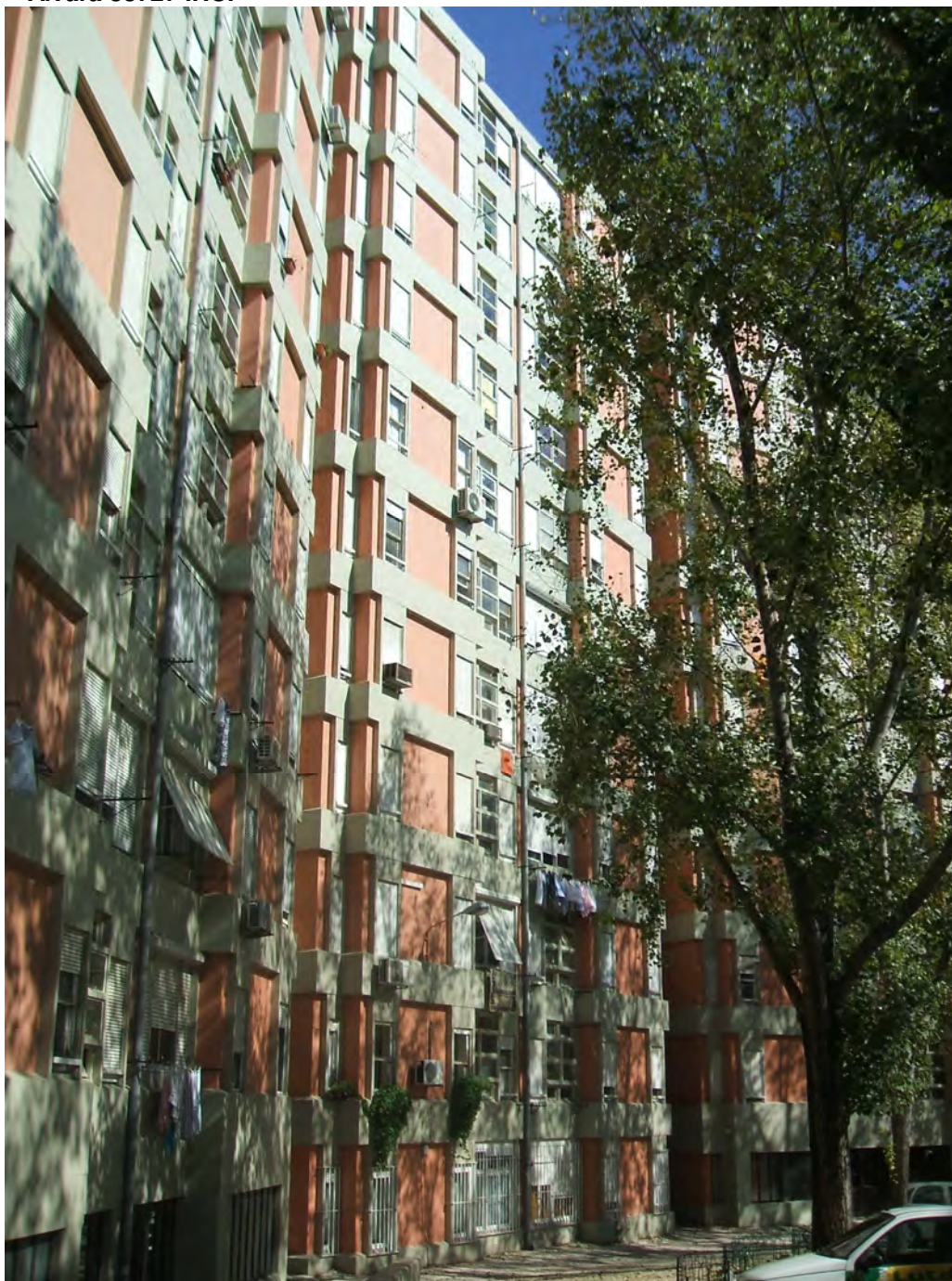
IASFA - Chelas – Substituição de caixilharias Alçado posterior do edifício antes da intervenção
