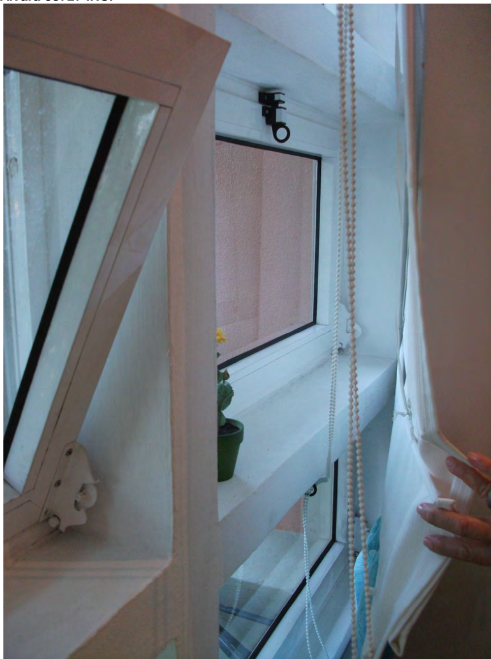
IASFA - Chelas – Substituição de caixilharias Vãos basculantes, depois da montagem
