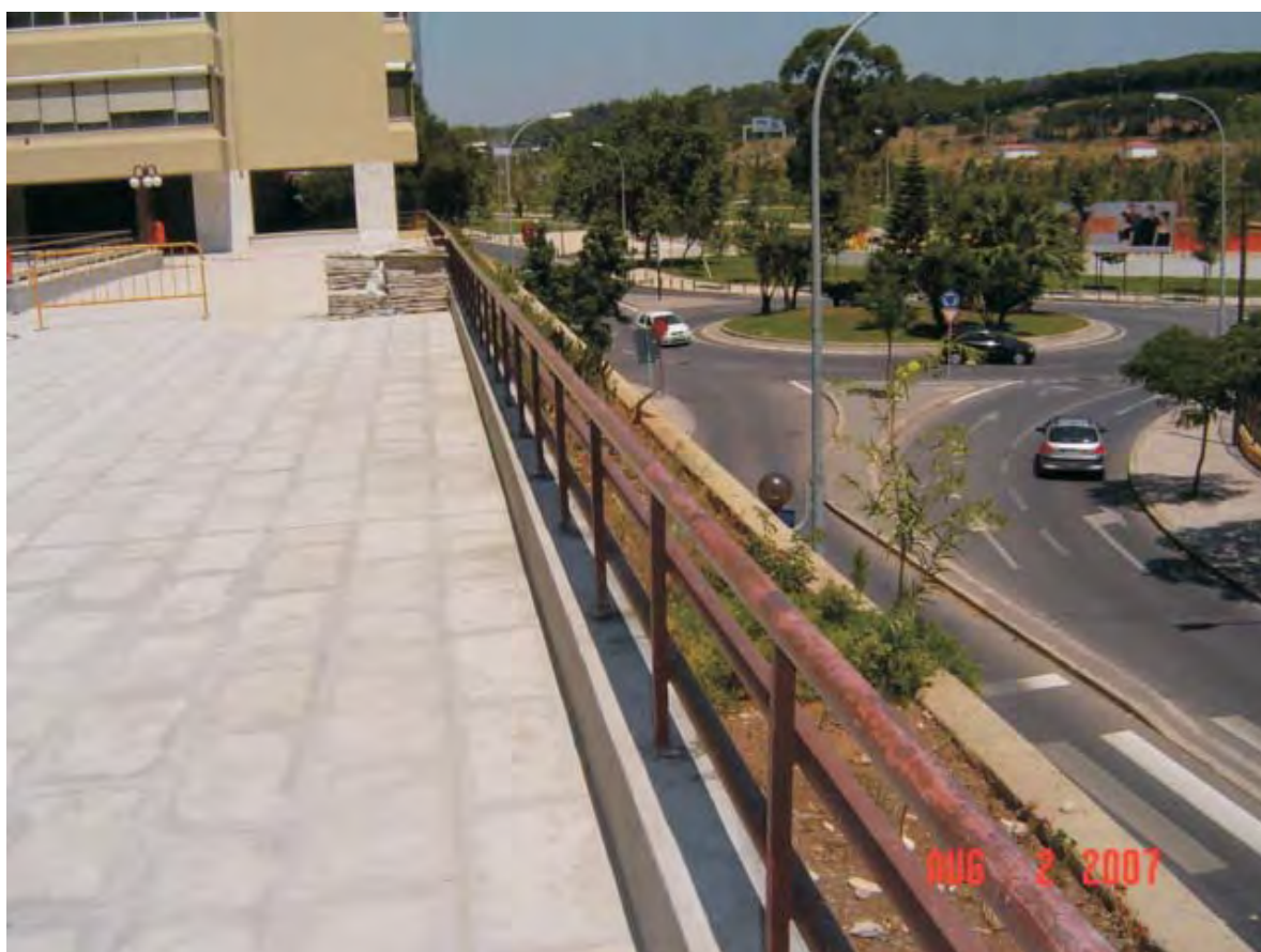
Condomínio em Miraflores - Renovação de Impermeabilização e Pavimento em terraço exterior
