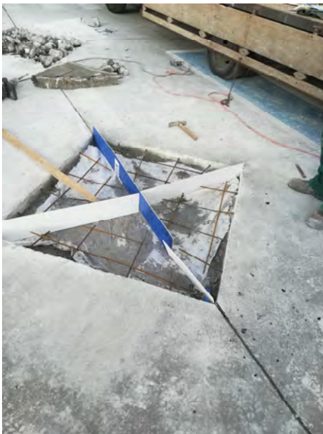
Reparação de Juntas de Dilatação, no estacionamento da cobertura.
