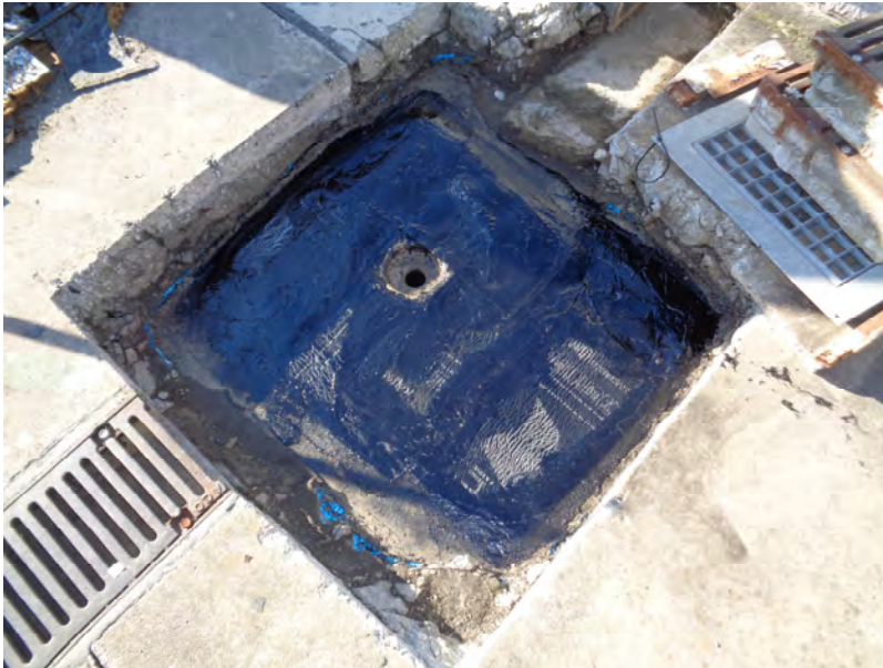
Reparação de Juntas de Dilatação, no estacionamento da cobertura.
